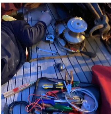
Maintenance du guindeau
