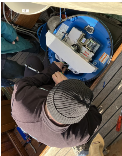
Maintenance du radar
