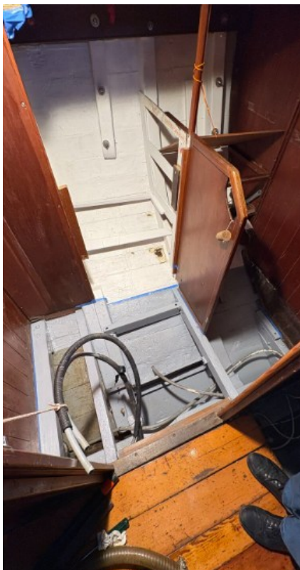
Réfection du cabinet de toilette
